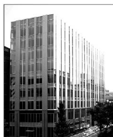
博多駅前スクエア (福岡県福岡市)
