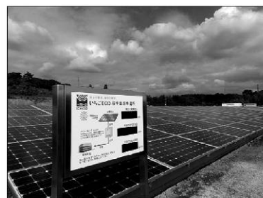
いちごECO桐生奥沢発電所 (群馬県桐生市)
