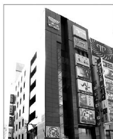
新橋SL広場前ビル (東京都港区)
