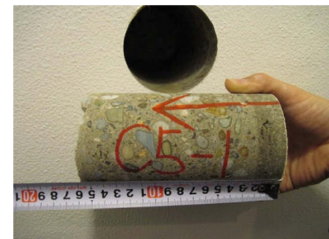
■ COI仙台中央ビル(D-6)耐震性検査
