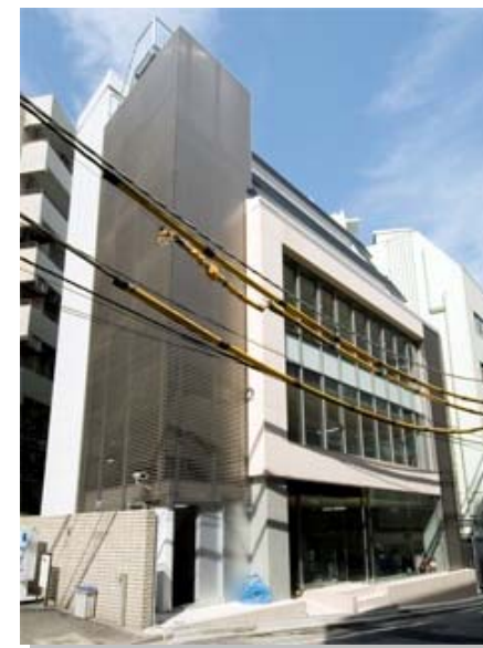
A-27 COI赤坂溜池ビル
