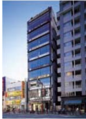
④-5 Asakusa Kaminarimon SIA Building 浅草雷門SIAビル
