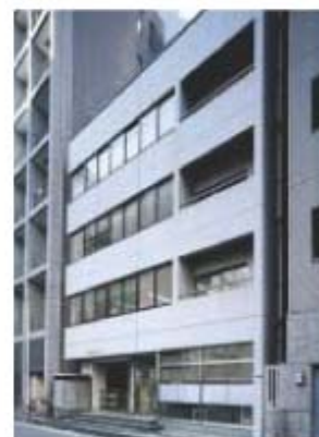
Ginza Todoroki Building 銀座轟ビル
