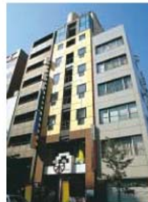
Shinbashi Sky Building 新橋スカイビル
