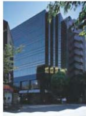
④-10 Technos Nakano Building テクノス中野ビル
