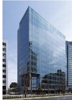
いちご花京院ビル (宮城県仙台市)
