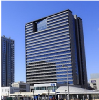
トレードピアお台場 (東京都港区)
