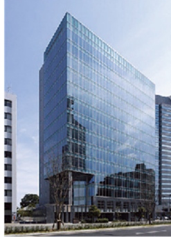
いちご花京院ビル (宮城県仙台市)
