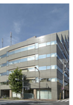
いちご池之端ビル
