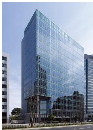
いちご花京院ビル (宮城県仙台市)
