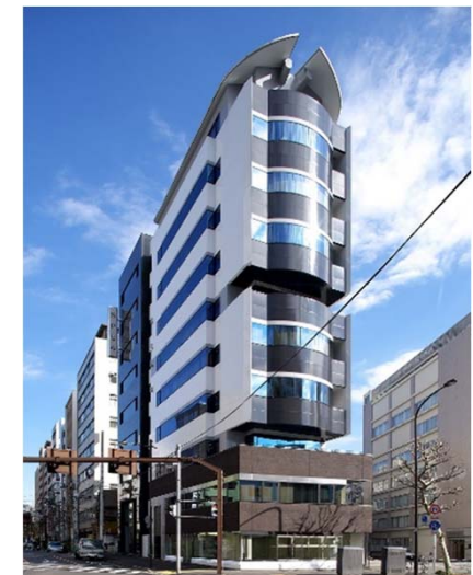
いちご内神田ビル(外観)
