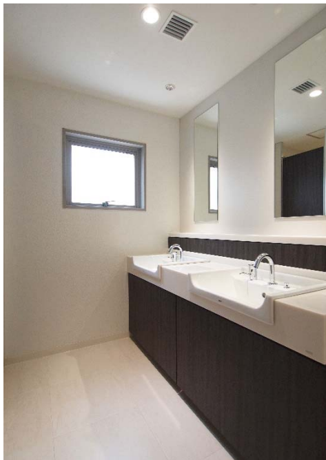
トイレ・リニューアル工事
