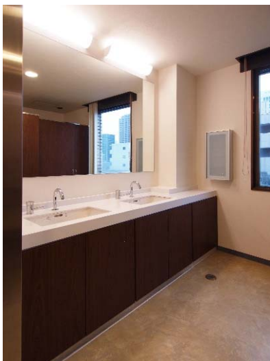
トイレ・リニューアル工事
