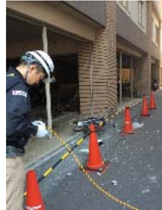
建物点検と緊急安全措施
