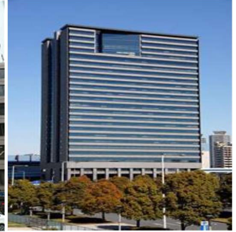
トレードピアお台場 (東京都港区)
