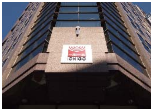
いちご神田小川町ビル
