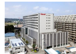
いちご富山駅西ビル
