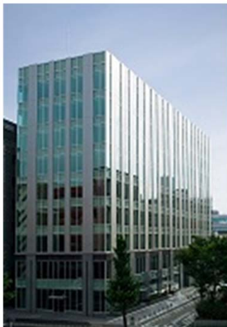
博多駅前スクエア (福岡県福岡市)
