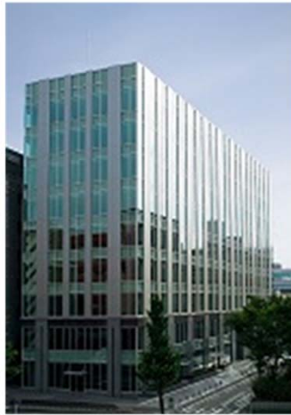
博多駅前スクエア (福岡県福岡市)
