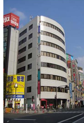
吉祥寺セントラルビル (東京都武蔵野市)
