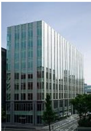
博多駅前スクエア (福岡県福岡市)
