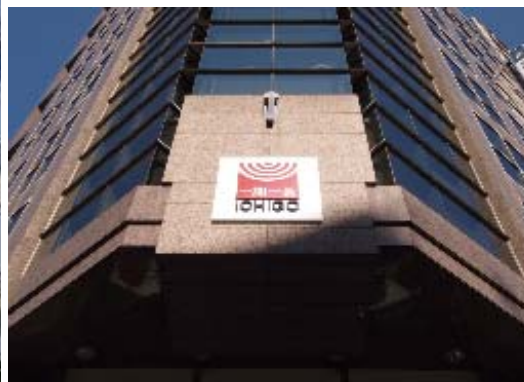
いちご神田小川町ビル
