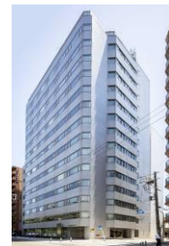
大阪西本町ビル
