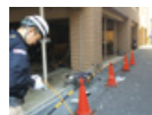
建物点検と緊急安全措置
