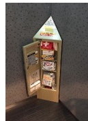
ELV内 防災キャビネット
